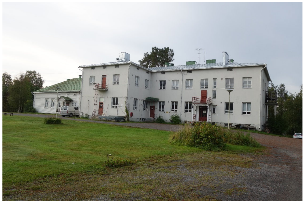
Kuva 14: Törmänhovi on maakunnallisesti merkittävä rakennus.
